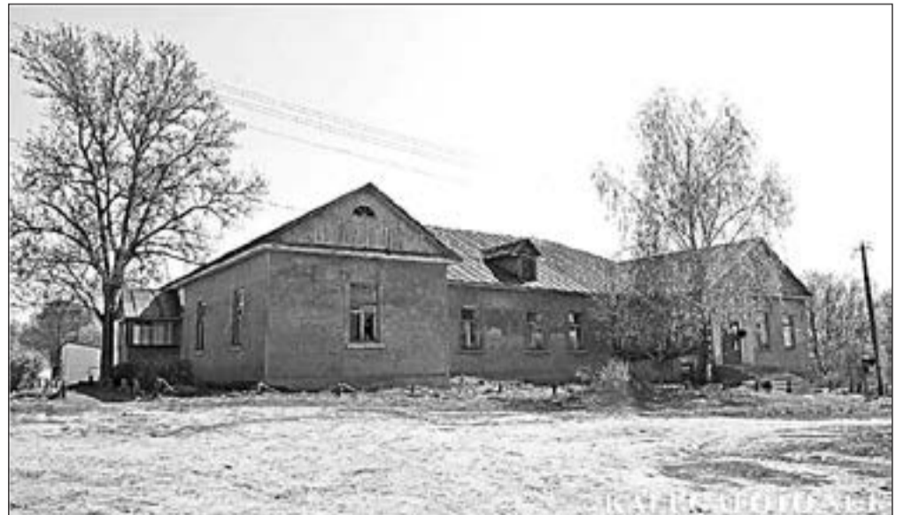
Деревянный господский дом в Попелёво. В 1980-е годы был обложен кирпичом, позднее оштукатурен. Сейчас в нём почта.
