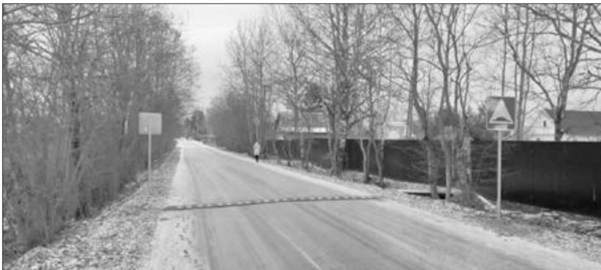
В Кобралово проведены работы по обустройству искусственных дорожных неровностей. Мероприятия провели по просьбе жителей.
