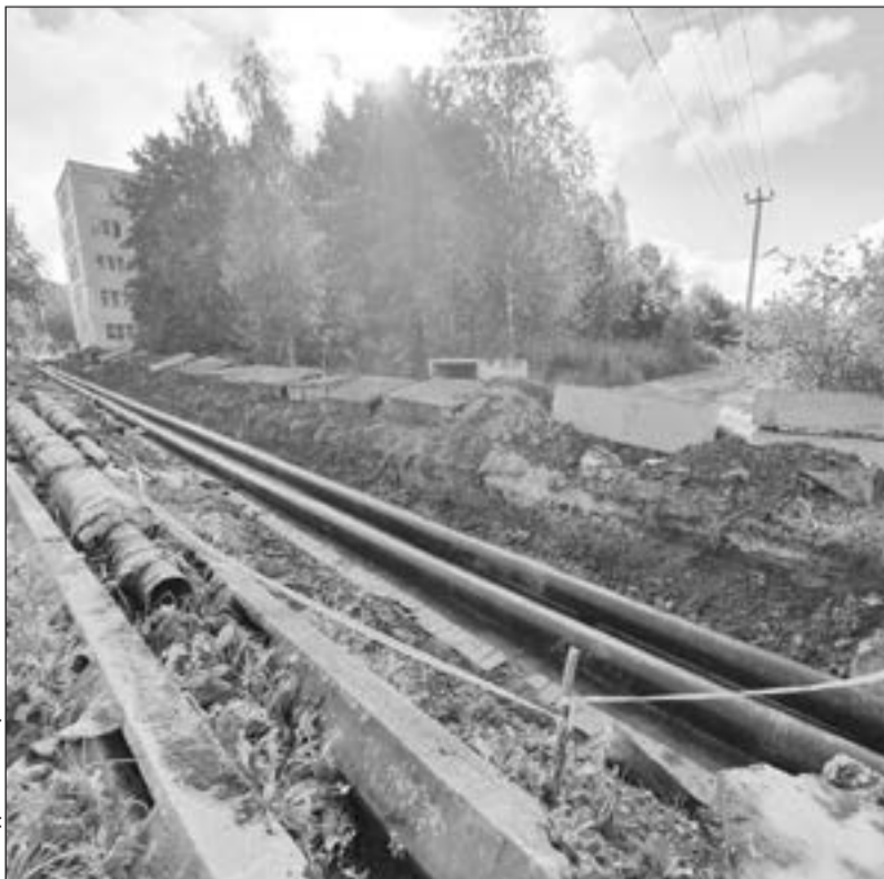
Перекладка участка теплотрассы в посёлке Кобралово.
