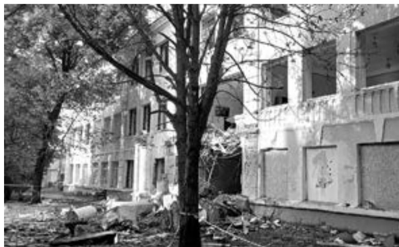
Разрушенное после обстрелов ВСУ здание школы в центре Донецка
