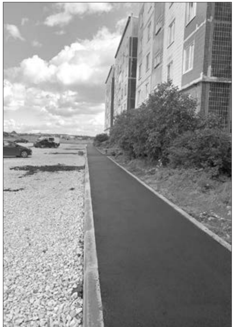
Ремонт дворовой территории в посёлке Терволово у дома №9.
