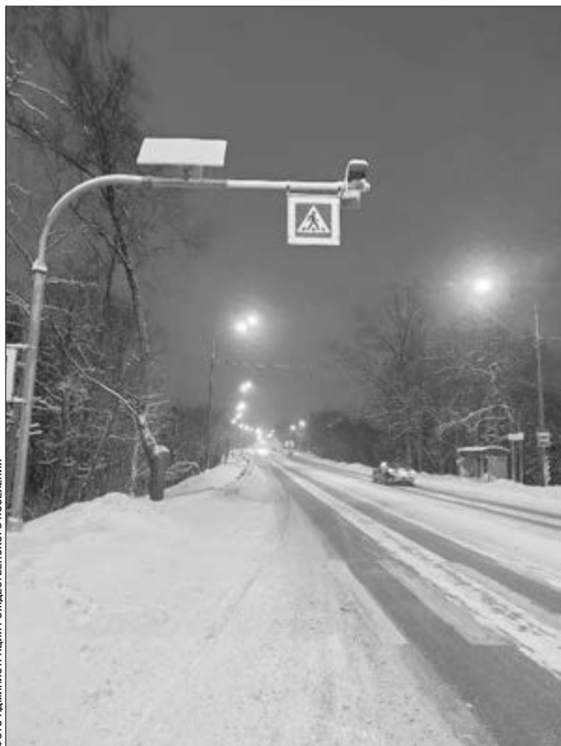
После совместных обращений главы администрации Рождественского поселения С.Н.Сорокина и депутата С.А. Опевалова на пешеходном переходе в деревне Выра (остановка «Выра ясли») установлен светофор.
