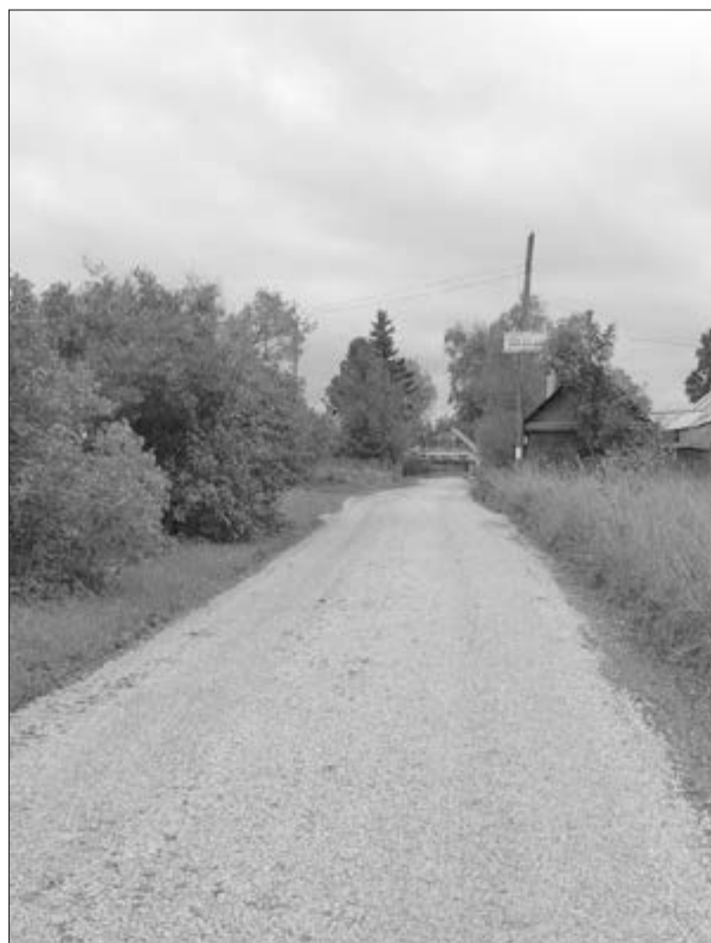
Провели ремонт части дороги по ул. Песчаная в Рождествено.
