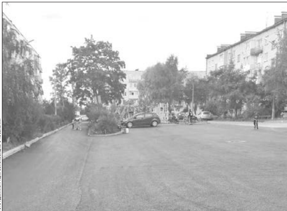
Ремонт придомовой территории д. 5, площадь Усова в п. Новый Учхоз.
