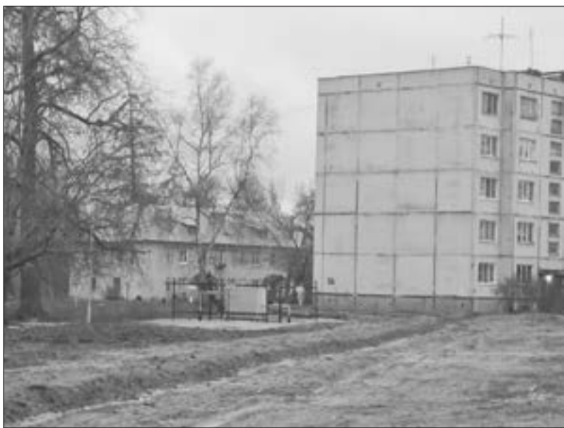
В селе Воскресенское завершилось строительство распределительного газопровода.
